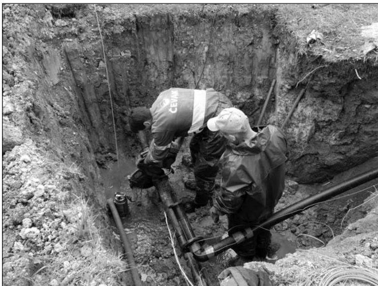
Pracovníci Čevaku při opravě vodovodu na náměstí
