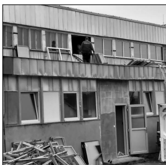
Výměna oken v tělocvičně
