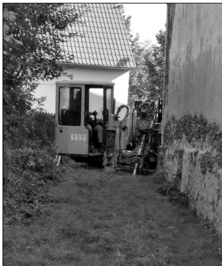
Podvrt pro vodovod
