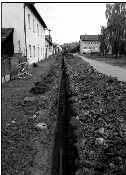
Oprava vodovodu na Výhoně
