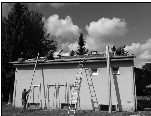
Výměna střechy na klubovně v Ratibořicích
